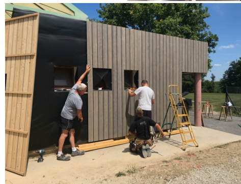
Pose du bardage en bois autour de la salle polyvalente.
