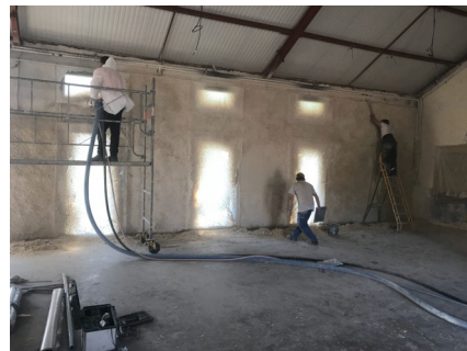
Flocage du béton de chanvre...
