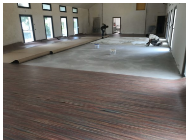
Pose du linoléum (ci-dessus) et premiers allumages des nouveaux luminaires... (ci-dessous).
