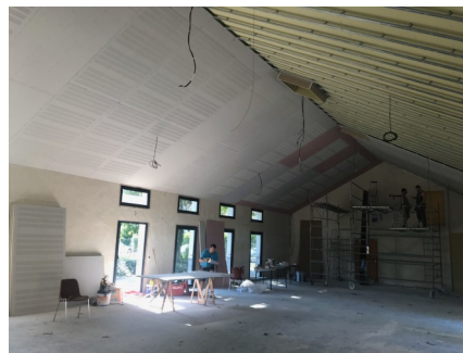
Flocage du béton de chanvre...
