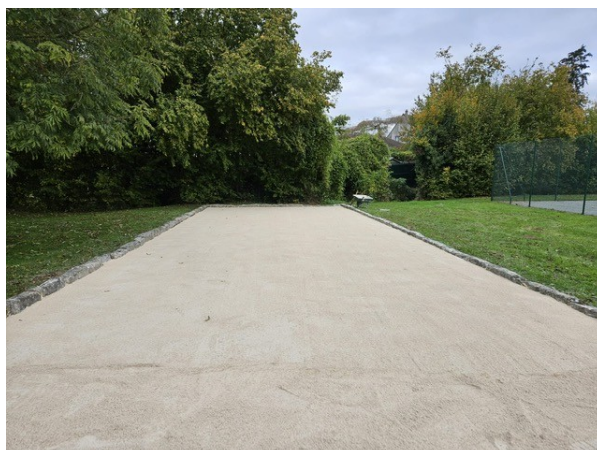
PRÉPARATION DU TERRAIN POUR LA MISE EN PLACE D'UNE BÂCHE INCENDIE RUE DE PERREUSEE
